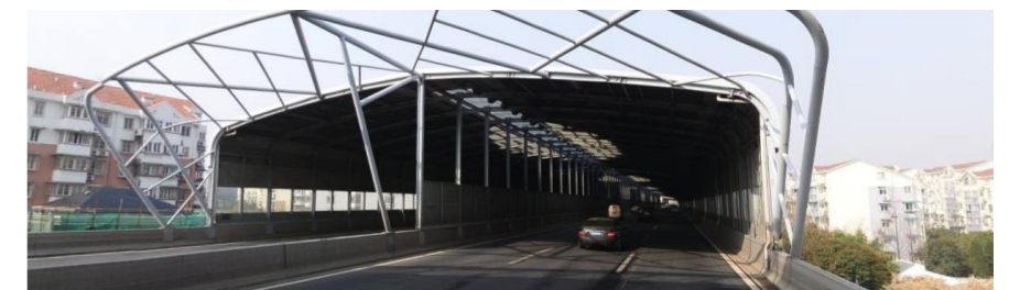
高架两侧隔音板遮挡——江北大道快速路高新南路段
