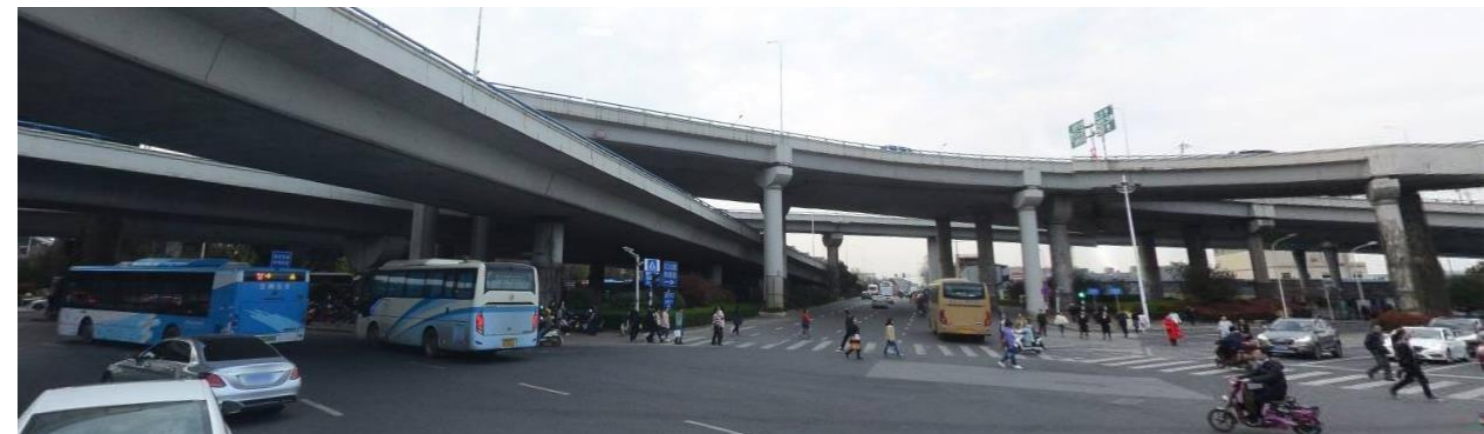
立体 交通枢纽 遮挡——新庄立交枢纽
