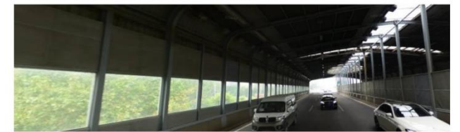
高架两侧隔音板遮挡——应天高架江东中路以西路段
