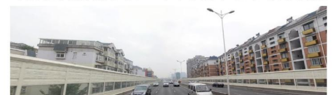
高架两侧隔音板遮挡——应天高架江东中路以东路段
